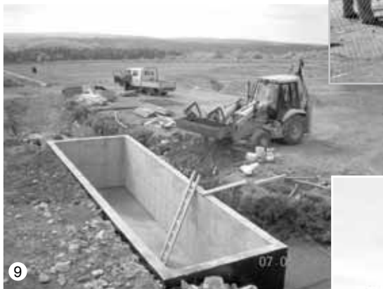
Akumulační nádrž u fotbalového hřiště ve Vavřinci
