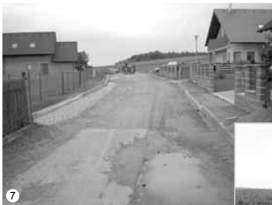
Práce na komunikaci Vavřinci
