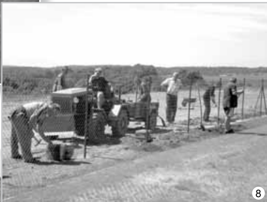
Práce na fotbalovém hřišti ve Vavřinci
