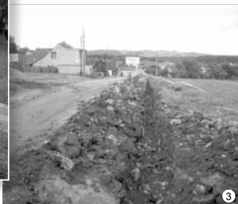
Kabelizace rozvodů Nn v Suchdole
