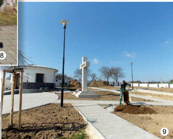
Dokončovací práce na hřbitově
