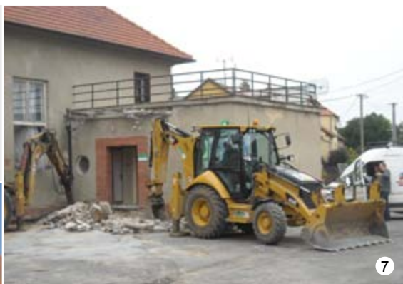
Budování bezbariérového vstupu do KD Veselice
