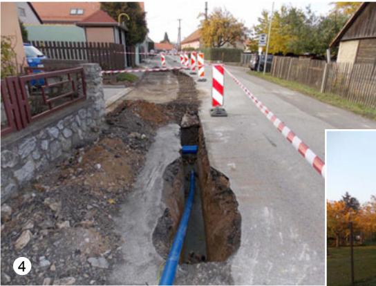
Prodloužení vodovodního řadu ve Veselici
