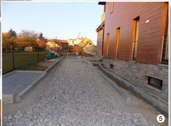
Rekonstrukce KD Veselice
