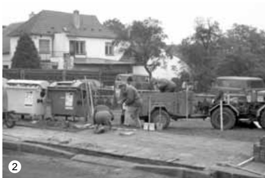
Úpravy stanoviště nádob na odpady ve Veselici
